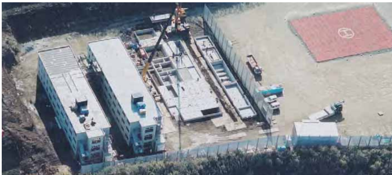
建設中の伊豆避難施設
