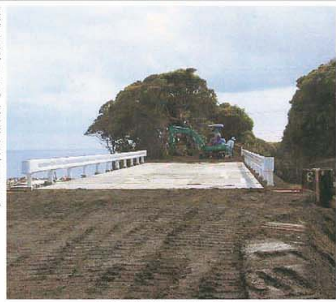
仮橋が完成した「芦穴沢」
