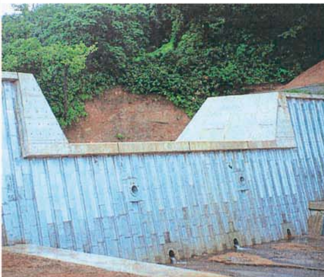
鋼製砂防ダム
