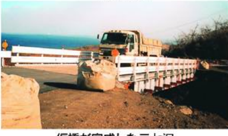
仮橋が完成した三七沢
