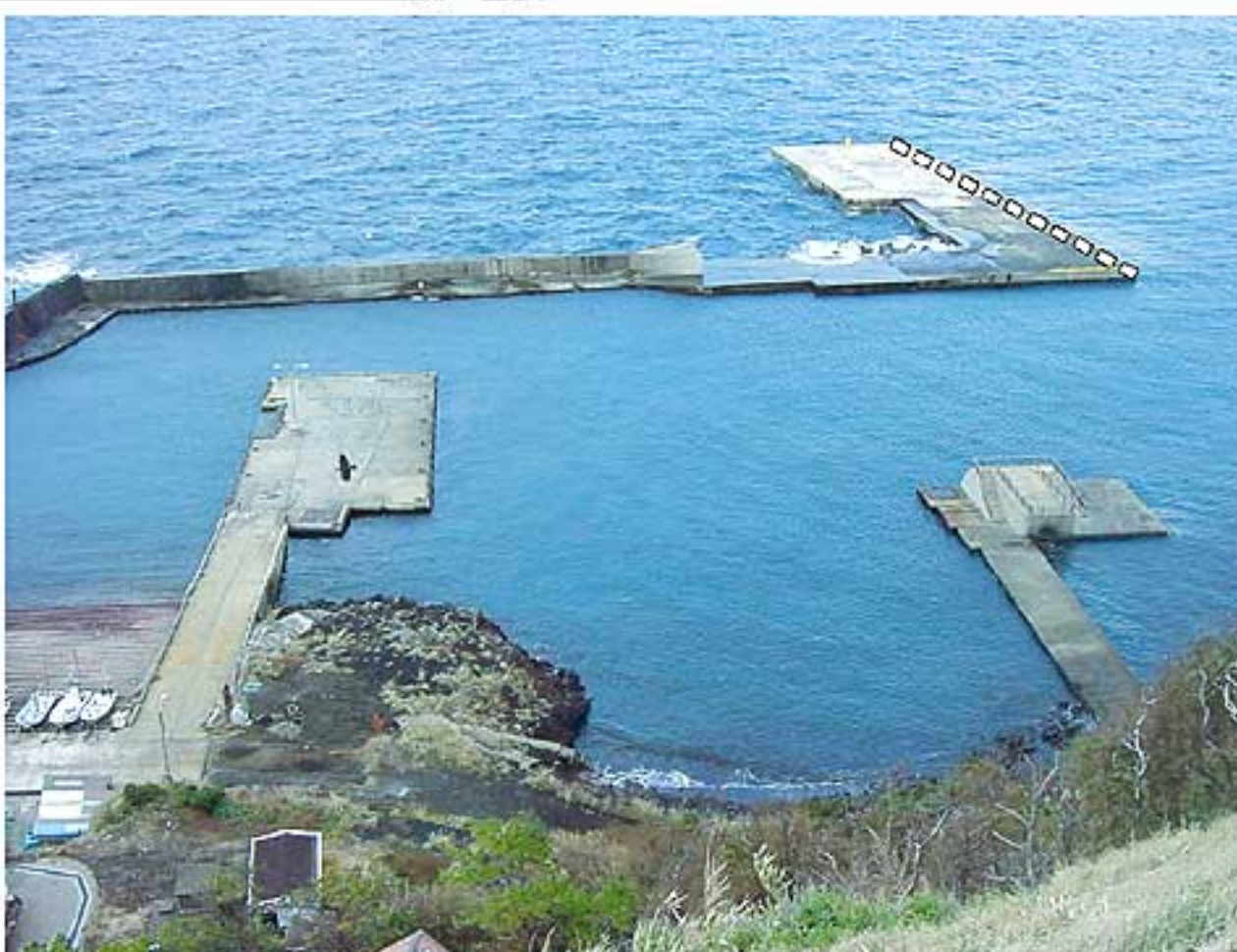
総延長100%になった「伊ヶ谷漁港岸壁」(右上の点線部分)
