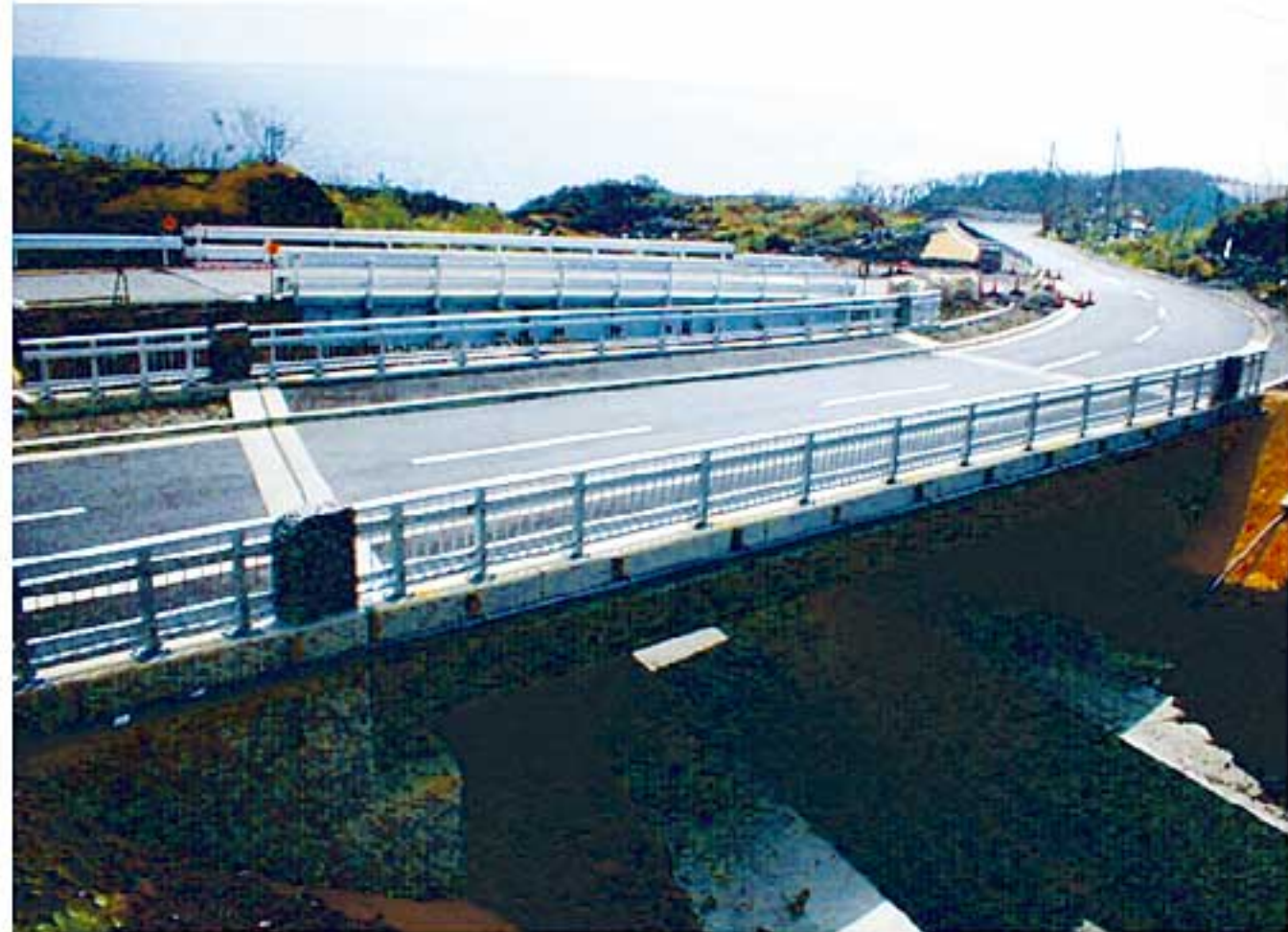
供用が開始されたカニガ沢橋 (写真手前)
