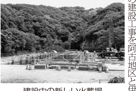
建設中の新しい火葬場
