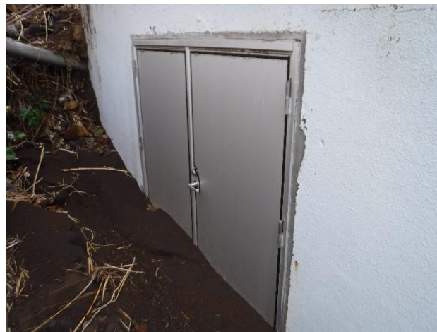
ポンプ小屋 入口
