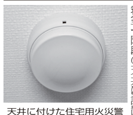
天井に付けた住宅用火災警報器(直径11センチ×高さ8センチ)
